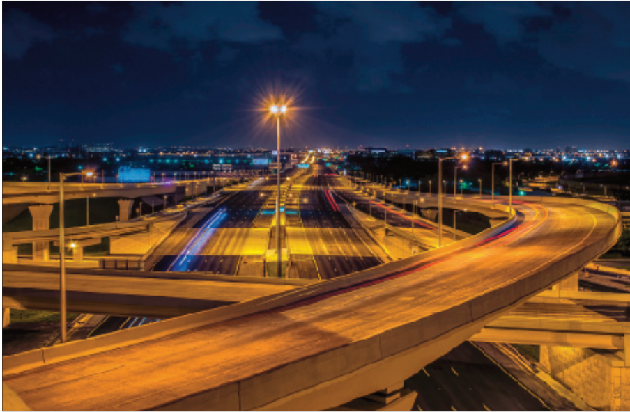
USA CONDOTTE Svincolo autostradale
